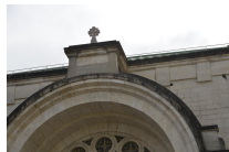
Croix anciennement sur la façade Berruyer de Notre-Dame déposée en 1990.
